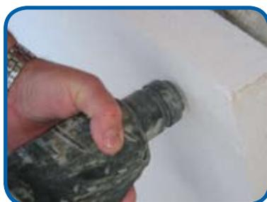
Il pannello viene forato utilizzando una punta di 8 mm. di diametro e con adeguata lunghezza (vedi tabella scheda tecnica pag prec.). Si raccomanda un utilizzo di min. 5 tasselli per m<sup>2</sup>.
